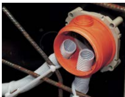
A KBT palástjába szerelt hajlékony csövek.
