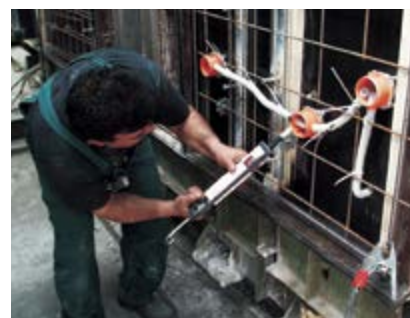
Az átvezetések tömítése (gitt).
