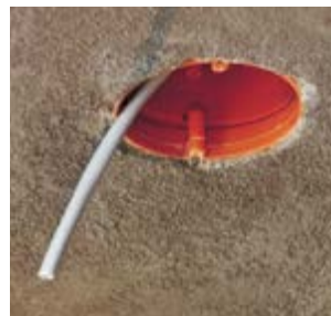
KBT típusú dobozok a KBP típusú csillárhorgok szereléséhez, előkészített, kivezetett kábellel.
